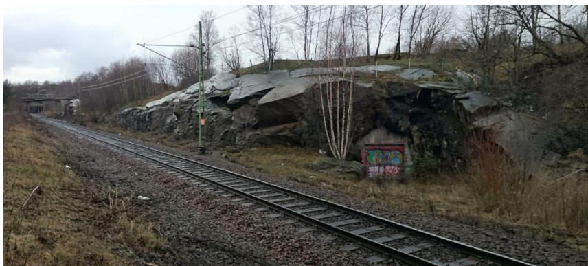
Figur 6.21 Bergskärningarna i NÖ delen av området Vy mot väster.
