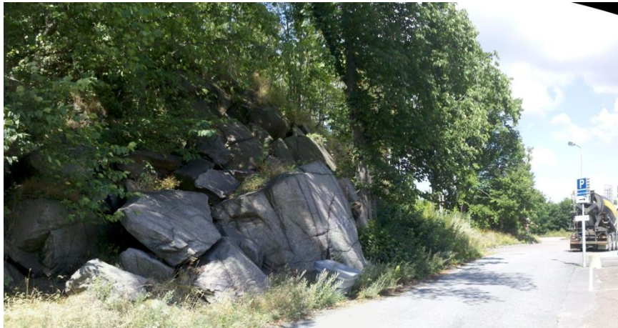
Figur 6.5 Naturlig bergslänt i Bratteråsgatan. Vy mot norr.
