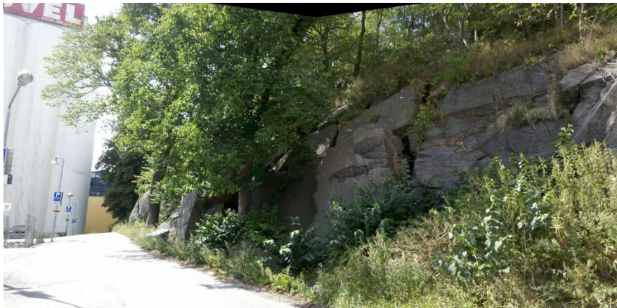
Figur 6.6 Naturlig bergslänt i Bratteråsgatan. Vy mot söder.
