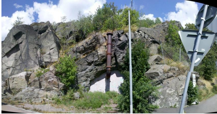
Figur 6.2 Delvis sprängd skärning i söder vid uppfarten från Valskvarnsgatan. Vy mot norr.
